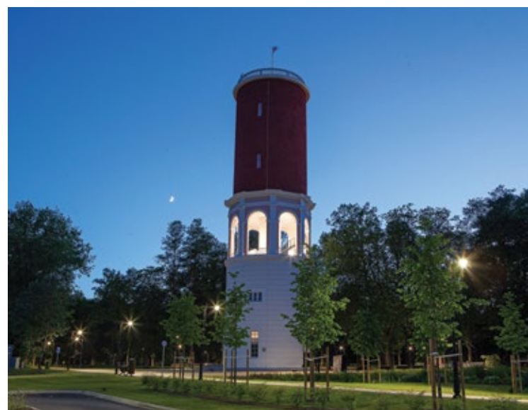
Ķemeru ūdenstornis tikko piedzīvojis vērienīgu rekonstrukciju, apmeklēt telpas un apskatīt tajās izvietotās ekspozīcijas varēs, tiklīdz to ļaus epidemioloģiskā situācija.
