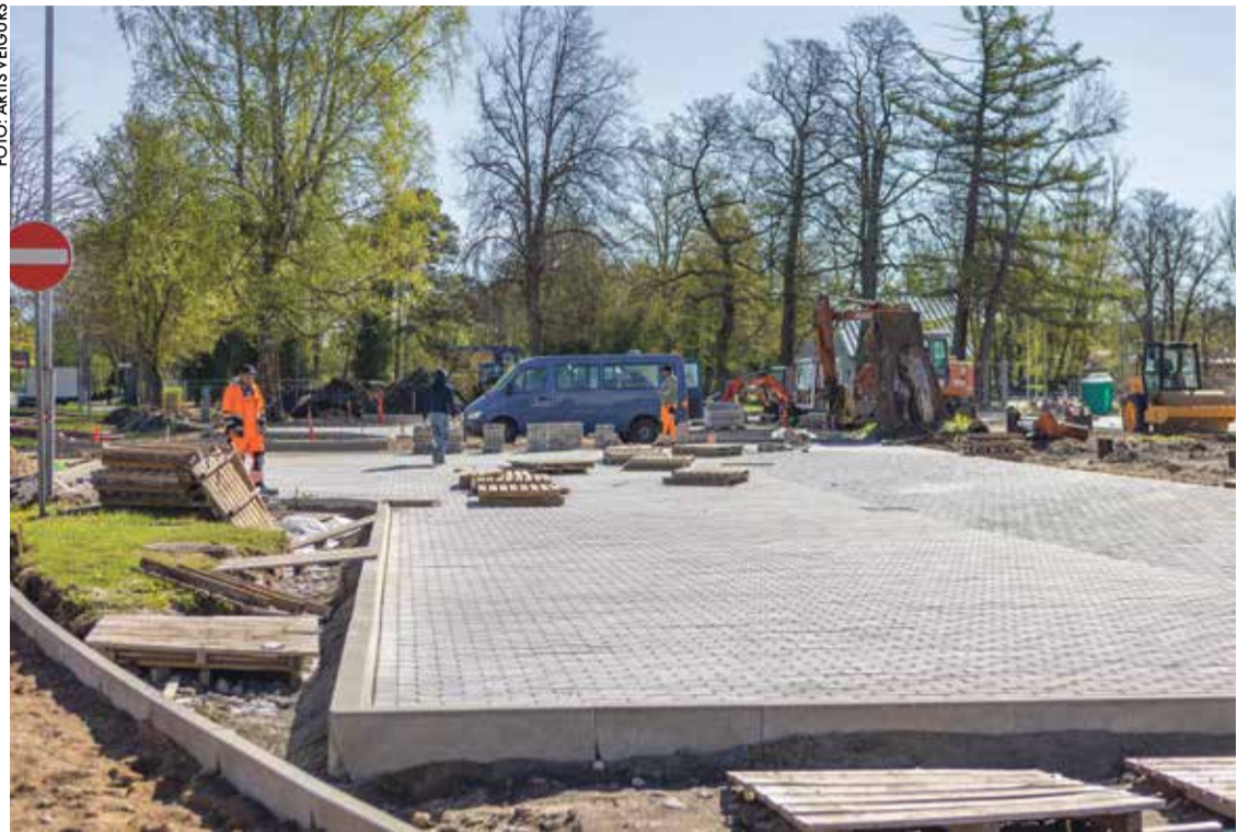
Pie Mellužu estrādes tiks izbūvētas 65 autostāvvietas, kā arī jaudīga lietusūdens kanalizācijas novadīšanas sistēma.
