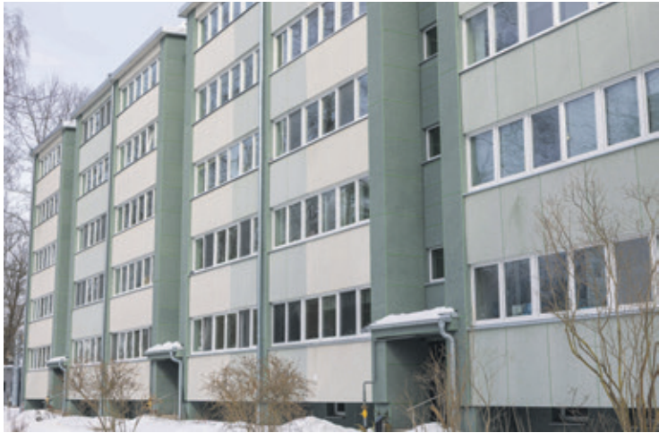
Pēc energoefektivitātes projekta īstenošanas Pliekšana ielas un Ormaņu ielas nama dzīvokļos samazināts enerģijas patēriņš un uzlabots arī ēku vizuālais izskats.
