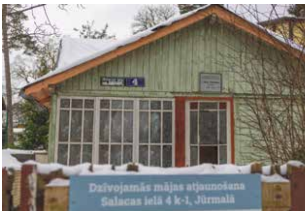
Ēkai Salacas ielā atjaunoti pamati, sienu un jumta konstrukcijas.
