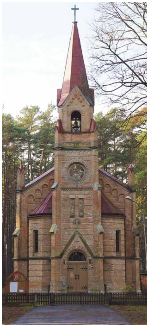
Bulduru evaņģēliski luteriskajai baznīcai ar pašvaldības līdzfinansējumu atjaunoti pieci logi, restaurētas durvis.
