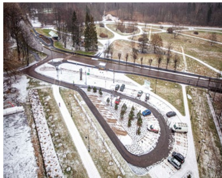
Atjaunota Tukuma ielas, Emīla Dārziņa ielas un Tūristu ielas brauktuve un gājēju ietvju segums, kā arī sabiedriskā transporta pieturvietas.
