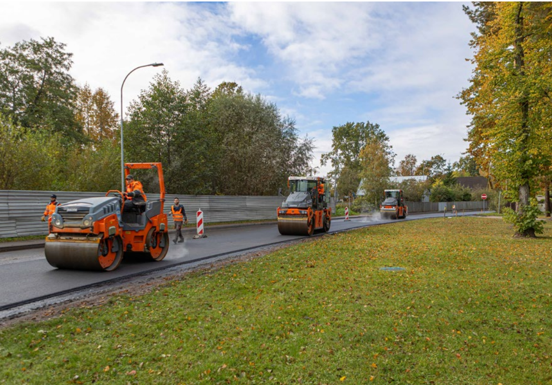
Apjomīgi būvdarbi veikti Strēlnieku prospektā, kur ieklāts jauns asfalta segums posmā no Kalēju ielas līdz Slokas ielai.
