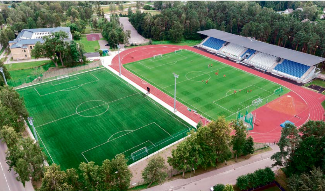
Pabeigta Jūrmalas stadiona “Sloka”, Skolas ielā 5, mākslīgā zāliena laukuma pārbūve, izbūvēts apgaismojums un veikti citi infrastruktūras labiekārtošanas darbi.
