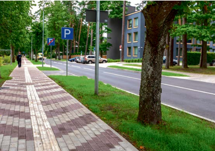
Atjaunots Piestātnes ielas segums, izbūvēta jauna lietus kanalizācijas sistēma un pilnībā pārbūvēta ietve.
