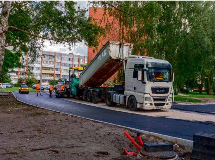
Pārbūves darbi Nometņu ielā. Daudzdzīvokļu namu pagalmā izbūvēs autostāvvietas 57 automašīnām.
