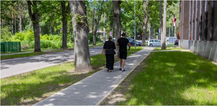
Dārzkopības ielas posmā līdz Viestura ielai atjaunotas ietves – ieklāts jauns betona bruģakmens.
