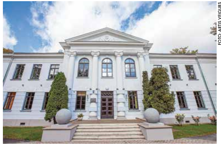
Nominācijā "Pārbūve" vērtēšanai izvirzīta Jūrmalas pilsētas Ķemeru pamatskolas ēka.
