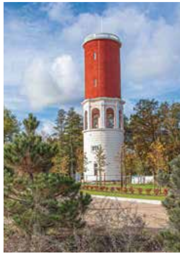
Ķemeru ūdenstornis izvirzīts vērtēšanai restaurācijas un inženierbūvju kategorijā.
