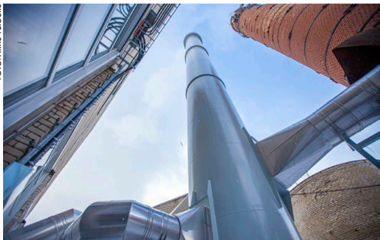
Jaunas biomasas katlumājas izbūve dos iespēju aizvietot dabasgāzi ar šķeldu, nodrošinot kvalitatīvu siltumapgādes pakalpojumu Kauguros.
