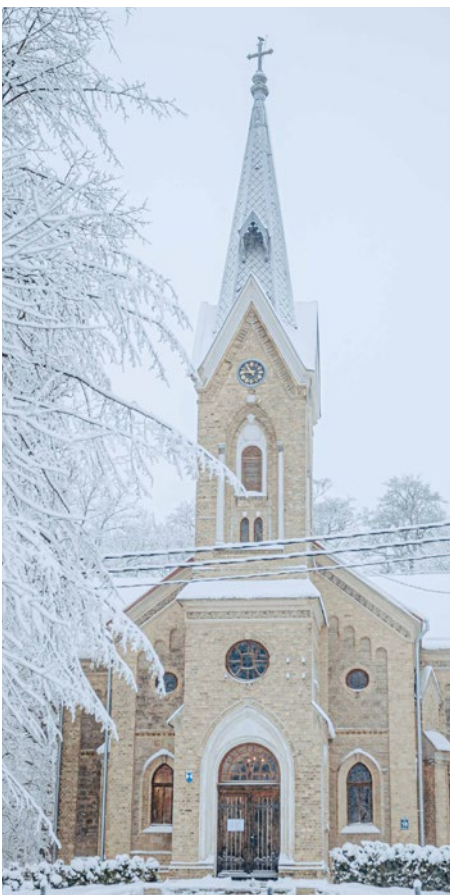
Ķemeru luterāņu baznīca ir aizsargājams valsts mēroga kultūras piemineklis. Piesaistot pašvaldības līdzfinansējumu, atjaunots zvans un tā nesošās konstrukcijas, torņa zvana elektroniskās zvanu sistēmas, iegādāts un uzstādīts fasādes pulksteņu apgaismojums.
