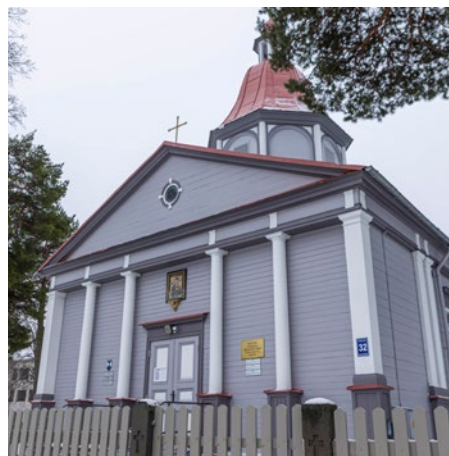
Atjaunota fasāde Majoru Romas katoļu draudzes baznīcai.
